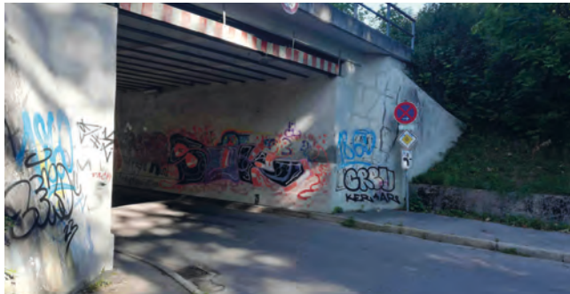
Schmaler Fußweg an der Unterführung Heinrich-Vogl-Straße
