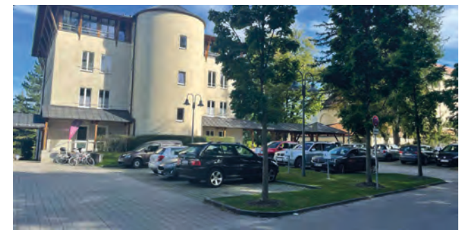
oberirdische Stellplatzfläche am Krankenhaus
