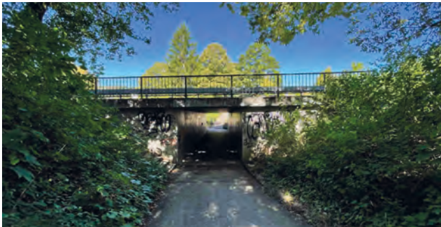
Unattraktive Unterführung an der Bernrieder Straße
