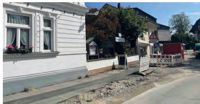
Sanierung der Hauptstraße
