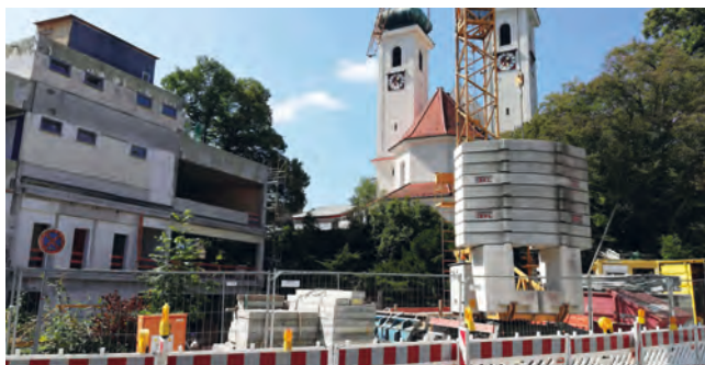
Sanierung der Grund- und Mittelschule
