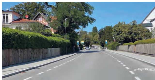
Radschutzstreifen an der Hauptstraße (Abschnitt Nord)
