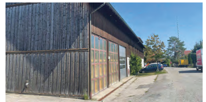
Bauhof der Gemeinde in Unterzeismering
