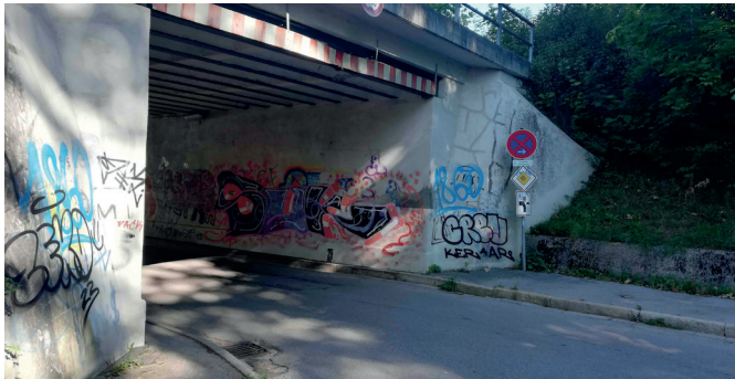
Schmaler Fußweg an der Unterführung Heinrich-Vogl-Straße
